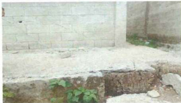
Foto 2: Vista exterior de cocina con grieta en paredes.
